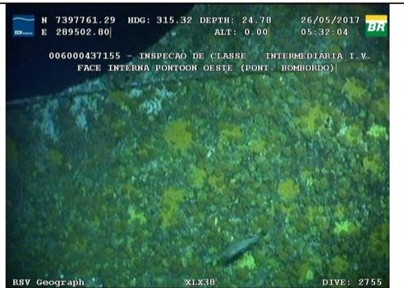
**Figura 6:** Colônias de coral-sol sobre a Face Interna Pontoon Oeste (Pontoon Bombordo).
