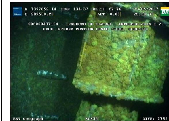
**Figura 3:** Colônias de coral-sol sobre Face Interna Pontoon Leste (Pontoon Boreste).
